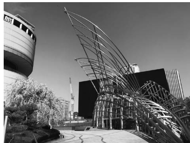
国立国際美術館エントランスゲート南側より望む、北側に見えるのは大阪中之島美術館
