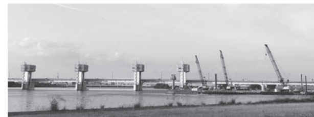
淀川大堰閘門 工事中 2025 年完成に向けて
